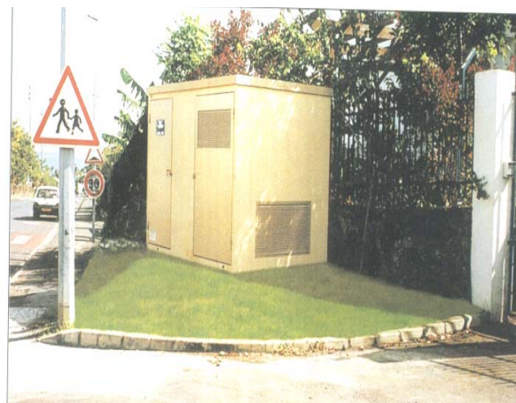
(الف): یک نمونه پست پیش‌ساخته کمپکت غیرفلزی
