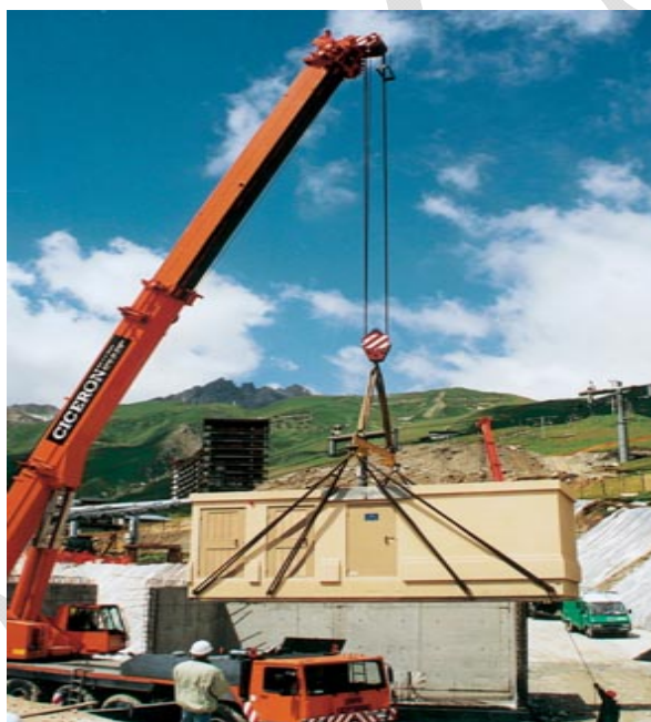
شکل (۱۶): طریقه جابجایی مناسب پست پیش‌ساخته کمپکت با استفاده از تسمه غیرفلزی و تیر حمل
