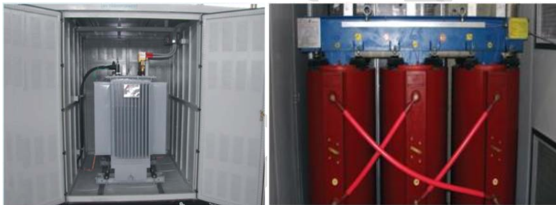
(ب): ترانسفورماتور توزیع روغنی هرمتیک
