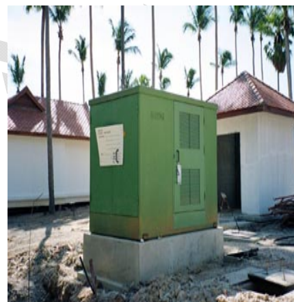
شکل (۱۱): نمونه‌ای از پست پیش‌ساخته کمپکت با احداث فونداسیون در محل
